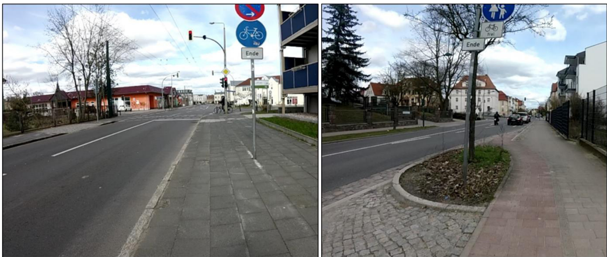
Abbildung 19: Ungesicherte Radwegeenden in der Schönholzer Straße (linkes Bild) und der Rudolf-Breitscheid-Straße (rechtes Bild)
