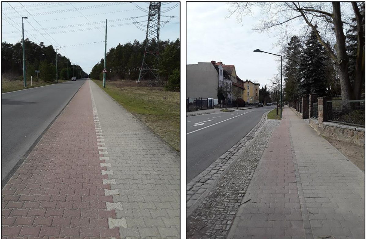
Abbildung 15: Geringe Wegebreiten und alte Radwegmarkierungen in der Schönholzer Straße (linkes Bild) und der Rudolf-Breitscheid-Straße (rechtes Bild)
