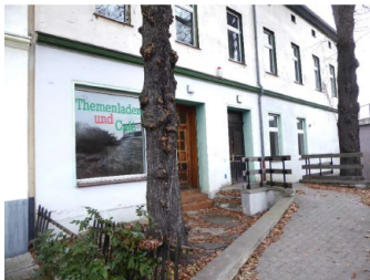
Ansicht straßenseitiger Eingangsbereich
