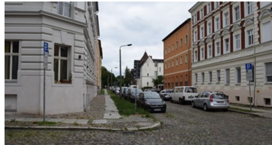
Eingeschränkte Sichtverhältnisse auf Querungsstelle in A.-Bebel-Straße
