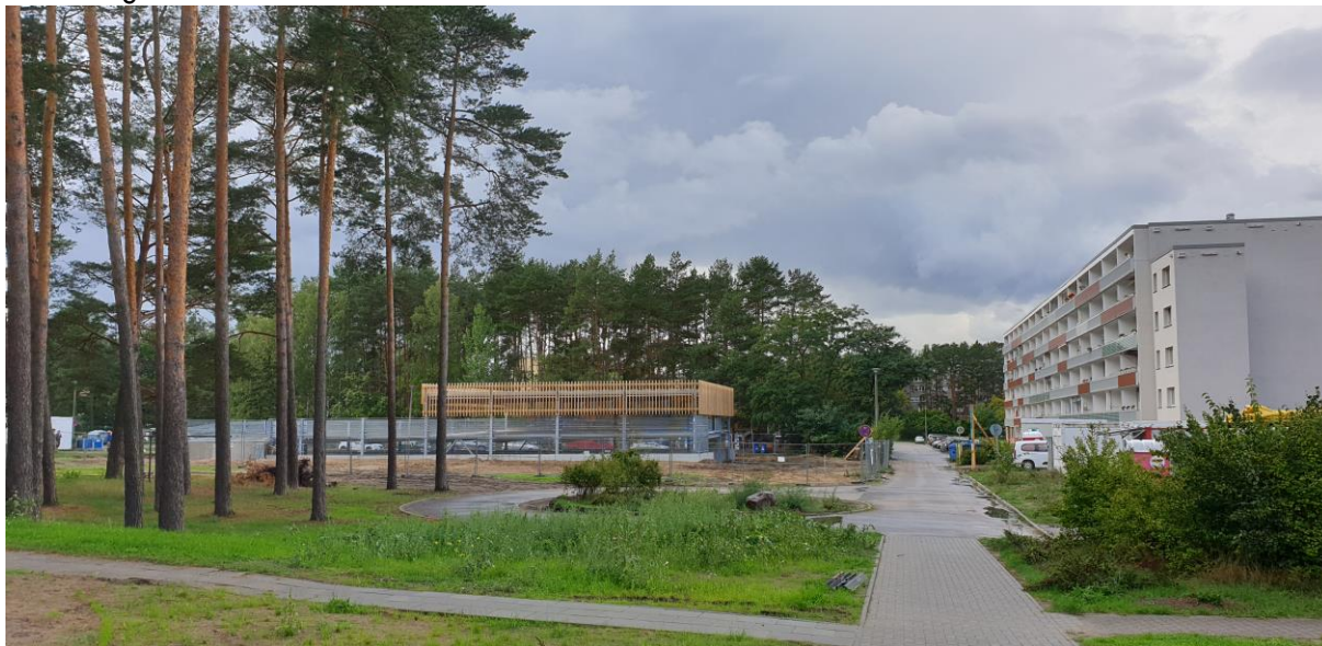
Abbildung 52: Frisch saniertem Wohnblock der Genossenschaft und Parkhausneubau
