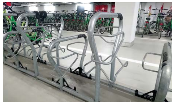
Abb. 13: Hoch-Tief-Einstellung im Fahrradparkhaus Potsdam
