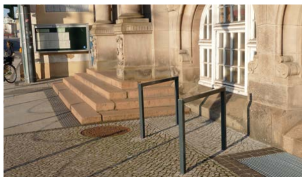
▲ Abb. 3: Radabstellanlage direkt neben dem Rathauseingang
