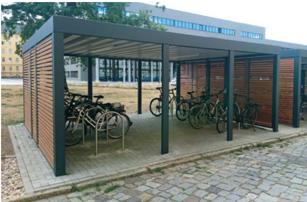
▲ Abb. 31: Radabstellanlage beim Ministerium für Infrastruktur und Landesplanung Brandenburg
