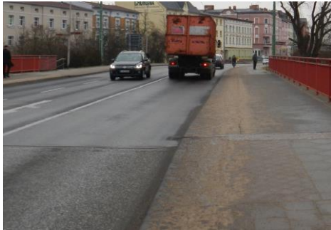
Abbildung 9: Verschmutzter Radweg Friedensbrücke
