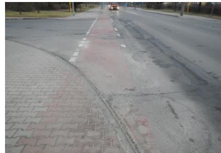
Abbildung 8: Verblichene Markierung in der Spechthausener Straße
