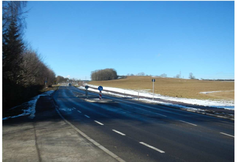
Abbildung: Beispielhafter Überführung Radweg - Fahrbahn in Tuningen
