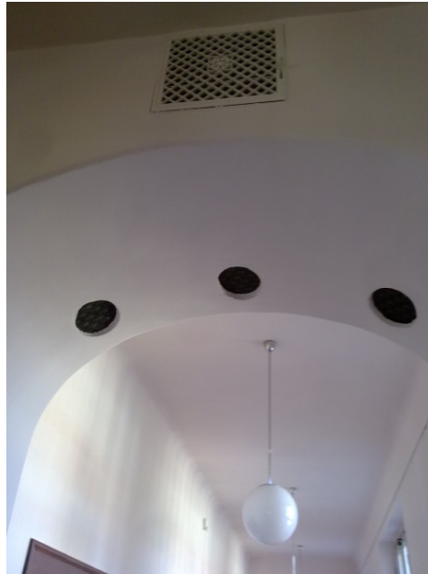
Mehrere Lüftungsgitter im Flur
