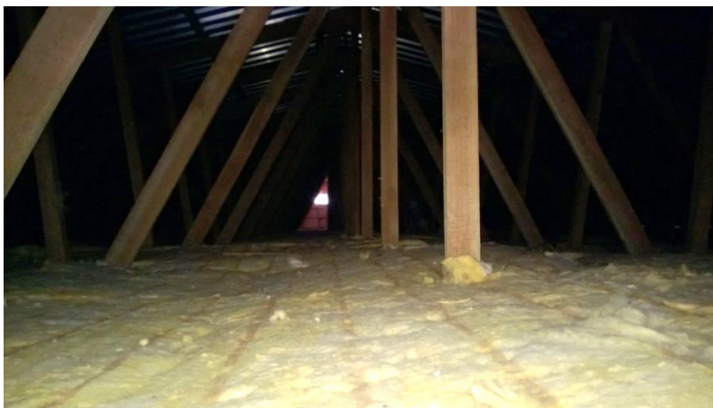
Dämmung Kaldach
