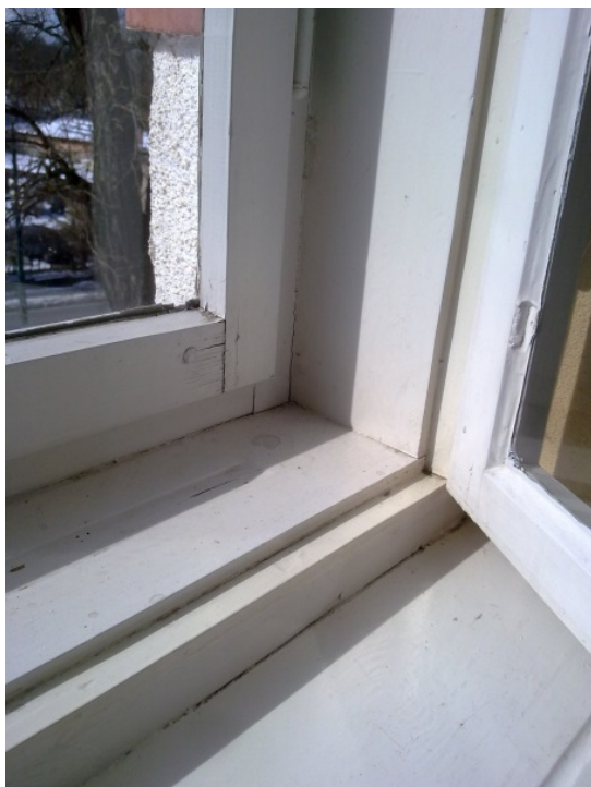
Kastenfenster ohne Dichtung
