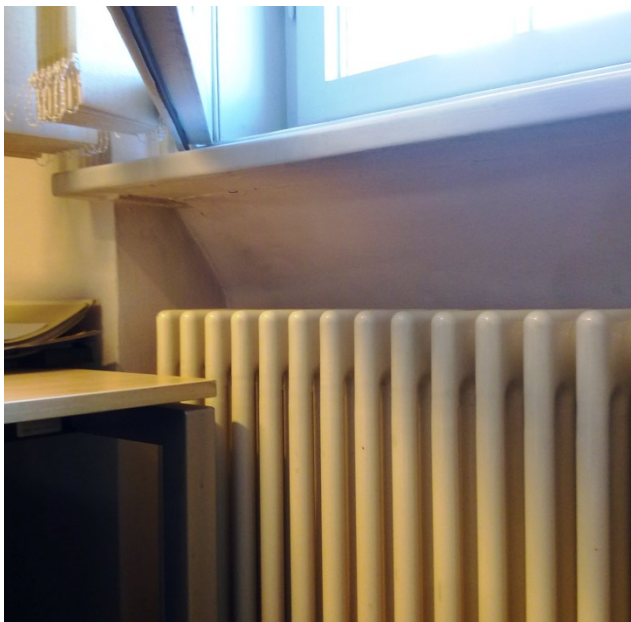
Ungedämmte Heizkörpernische
