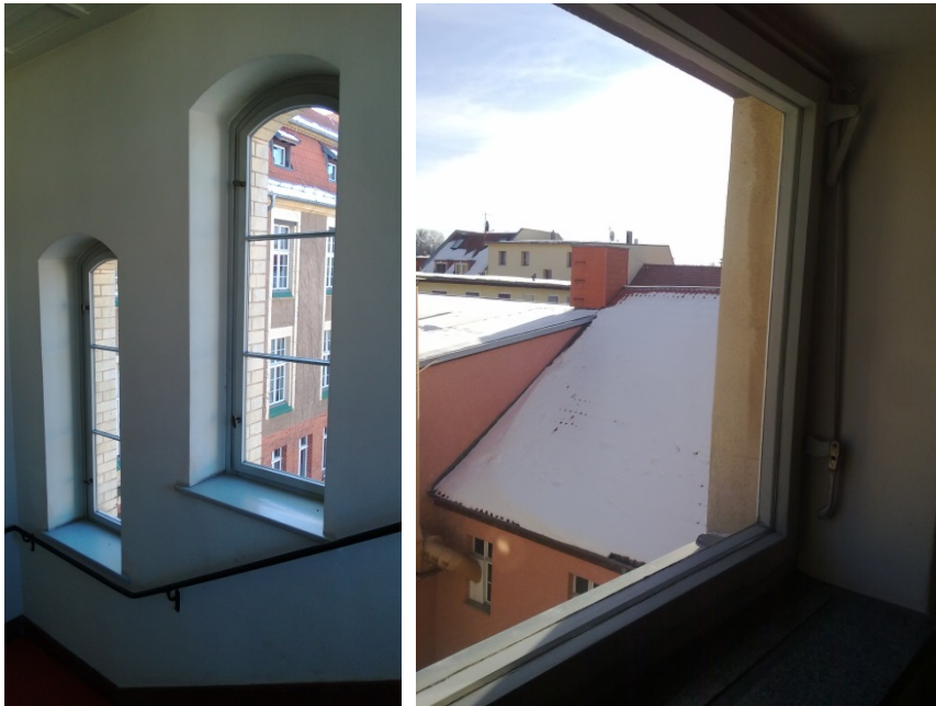
Einfachverglasung im TH Zweifachverglasung mit schlechtem U-Wert
