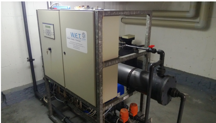
Spülwasser-Aufbereitungsanlage
