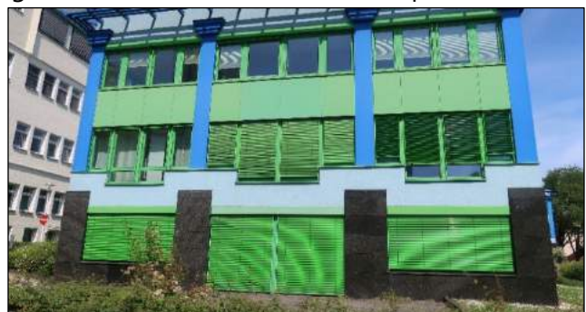
Abbildung 5: Gebäudeverschattung. © M. Olonscheck.
