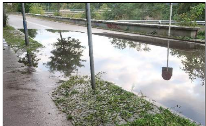
Abbildung 57: Nach einem Starkregen überflutete Straße. © M. Olonscheck.
