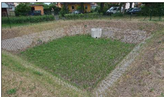
Abbildung 22: Regenrückhaltebecken an der Schönholzer Straße. © M. Olonscheck.
