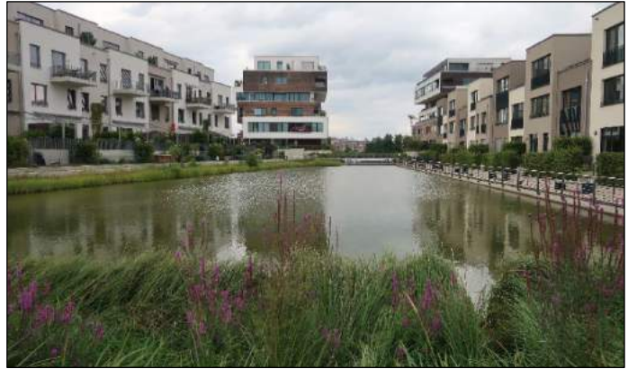
Abbildung 76: Schwammstadt Quartier 52° Nord. © M. Olonscheck.
