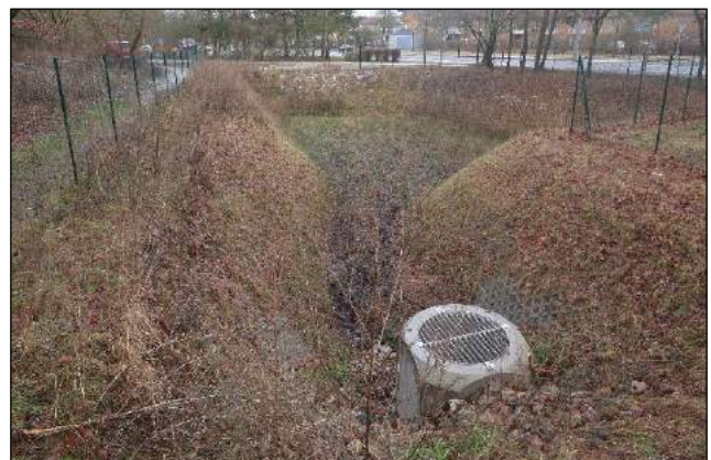
Abbildung 78: Regenrückhaltebecken im Brandenburgischen Viertel. © M. Olonscheck.
