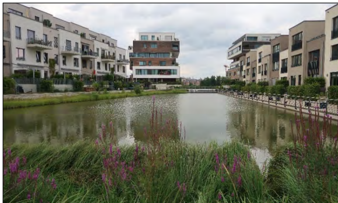
Abbildung 76: Schwammstadt Quartier 52° Nord. © M. Olonscheck.
