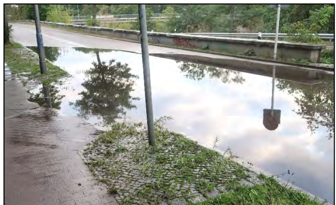
Abbildung 57: Nach einem Starkregen überflutete Straße. © M. Olonscheck.
