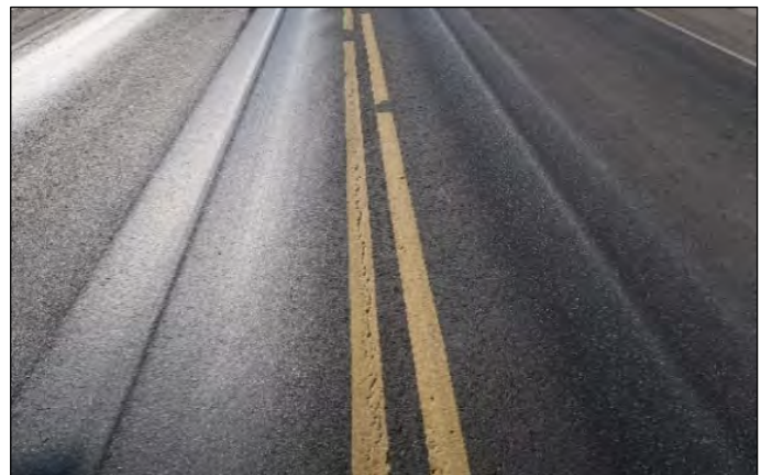
Abbildung 60: Spurrillen auf Asphalt. © M. Olonscheck.
