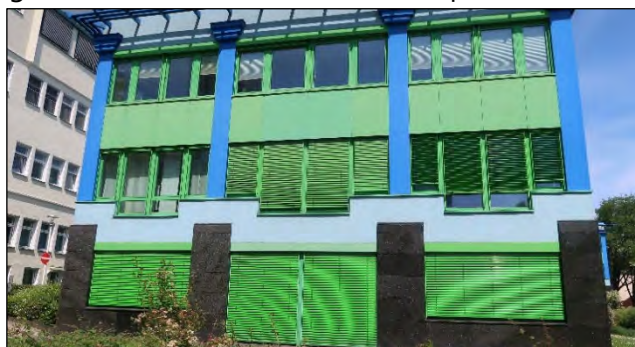
Abbildung 5: Gebäudeverschattung. © M. Olonscheck.
