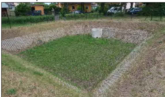
Abbildung 22: Regenrückhaltebecken an der Schönholzer Straße. © M. Olonscheck.
