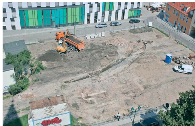
Nach den archäologischen Untersuchungen rücken erneut die Bagger an. Bereits im Dezember 2012 sollen die Kinder hier wieder rodeln können. Foto: Blitz/rb
