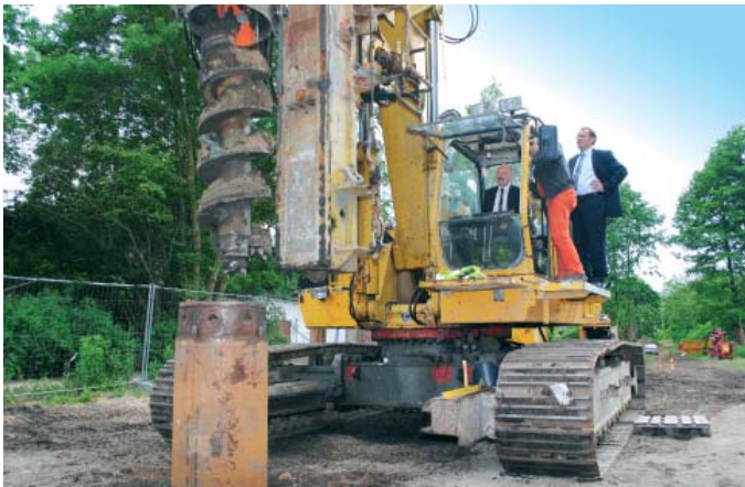
Mit der symbolischen „Pfahlgründung“ durch Friedhelm Boginski und Infrastrukturminister Jörg Vogelsänger, begannen die Baumaßnahmen. Foto: Blitz/bhw
