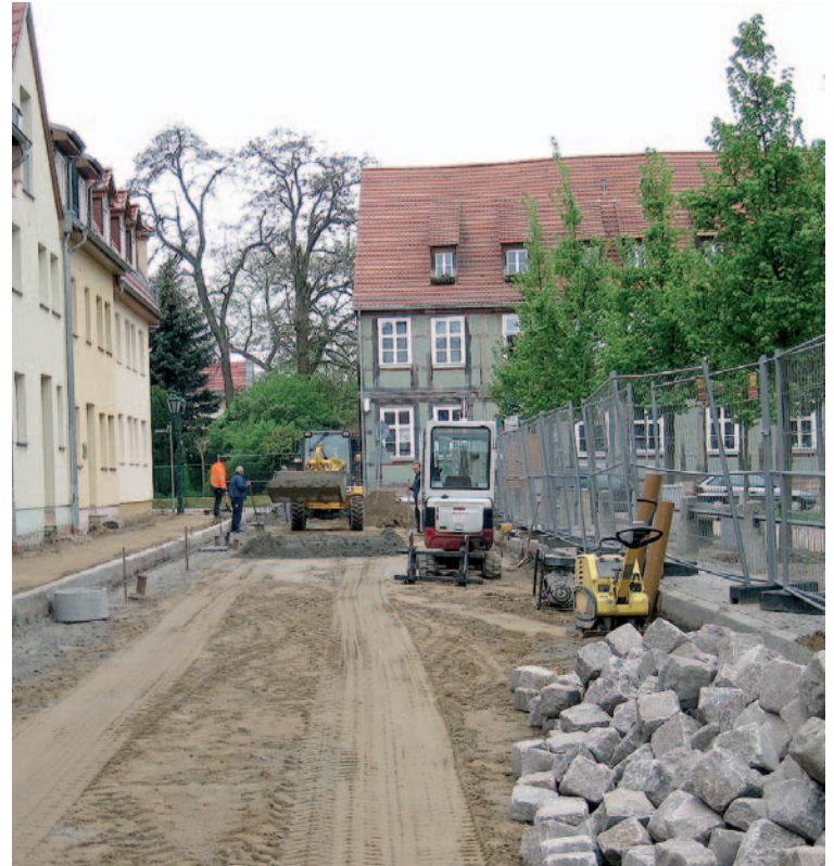
In Kürze wird der erste Bauabschnitt beendet
