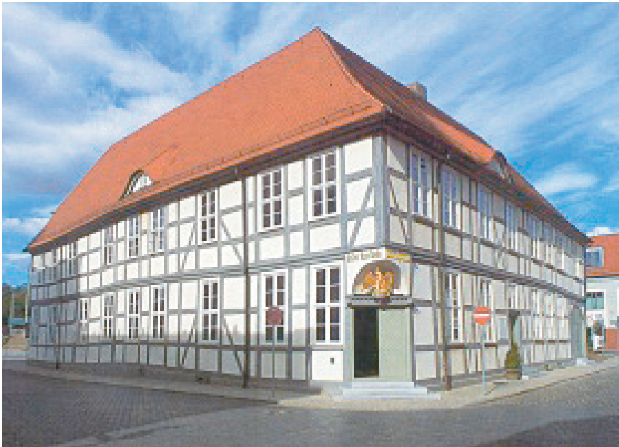
Das Museum in der Adler-Apotheke soll mit Hilfe der Gelder aus dem EFRE-Programm barrierefrei werden. Der Beginn der Arbeiten zum Einbau eines Aufzugs ist noch für dieses Jahr eingeplant.
