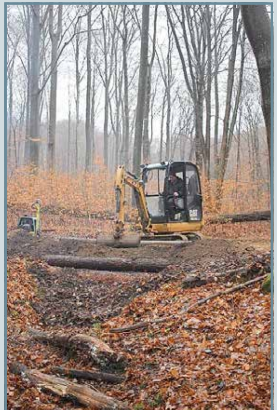
Links: Im Wald nordöstlich der Stadt verschließen freiwillige Helfer einen Entwässerungsgraben mit Lehm und Sand. Stämme und Äste dienen dem Erosionsschutz. Foto: Immo Wittgenfeld | Rechts: Im Stadtwald nahe des Ruheforstes arbeitet ein Kleinbagger an einer Furt. Hier sollen Winterniederschläge effektiver zurückgehalten werden. Foto: Oliver Jähnichen
