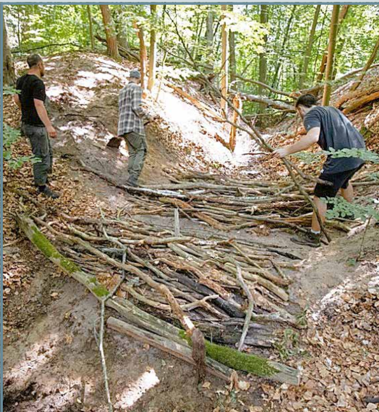
Links: Im Wald nordöstlich der Stadt verschließen freiwillige Helfer einen Entwässerungsgraben mit Lehm und Sand. Stämme und Äste dienen dem Erosionsschutz. Foto: Immo Wittgenfeld | Rechts: Im Stadtwald nahe des Ruheforstes arbeitet ein Kleinbagger an einer Furt. Hier sollen Winterniederschläge effektiver zurückgehalten werden. Foto: Oliver Jähnichen
