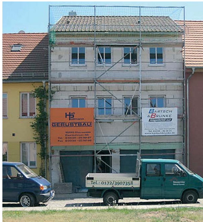
Das Haus in der Schweizer Straße steht kurz vor der Fertigstellung.
