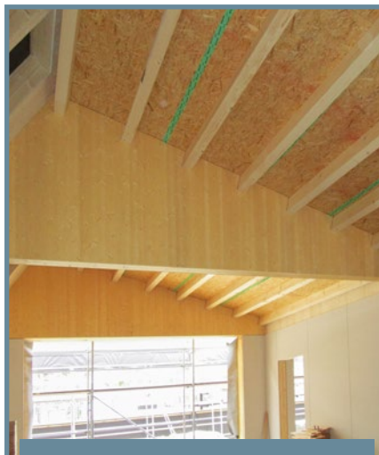
(2) Sheddach Hortneubau Kyritzer Straße
