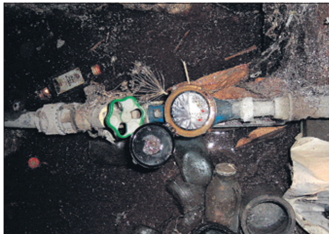
Eingefrorener Wasserzähler
