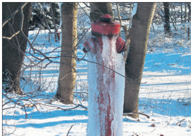
Eingefrorener Oberflurhydrant
