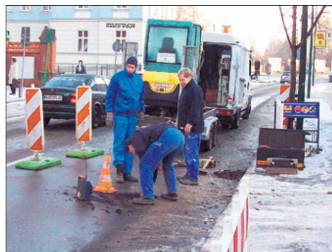
Beseitigung eines Rohrbruches in Eberswalde, Eisenbahnstraße
