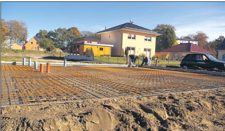
Blick auf das neue Quartier „Am Paschenberg“. Gerade entsteht eine Bodenplatte für einen weiteren Neubau.
