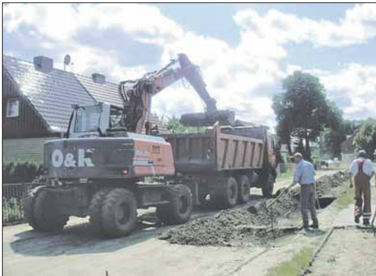
Neu entsteht gegenwärtig auch die Beethovenstraße in der Clara-Zetkin-Siedlung. Geplant ist, das Bauvorhaben bis Ende Oktober 2007 fertig zu stellen. Foto: Jennifer von Zobeltitz
