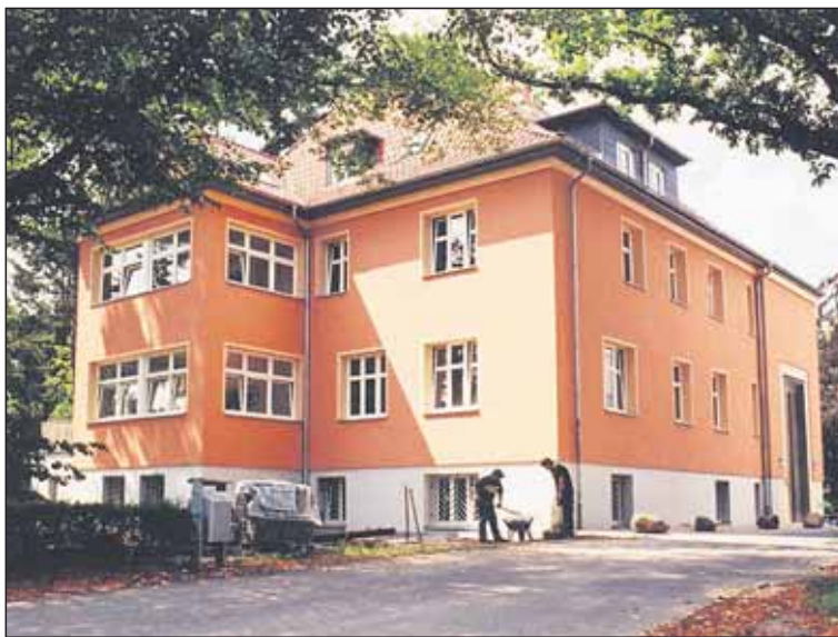
In Terrakotta erstrahlt das alte Wohnhaus in wunderschönem neuem Glanz. Balkone oder beheizbare Loggien runden die interessant geschnittenen Wohnungen ab.
