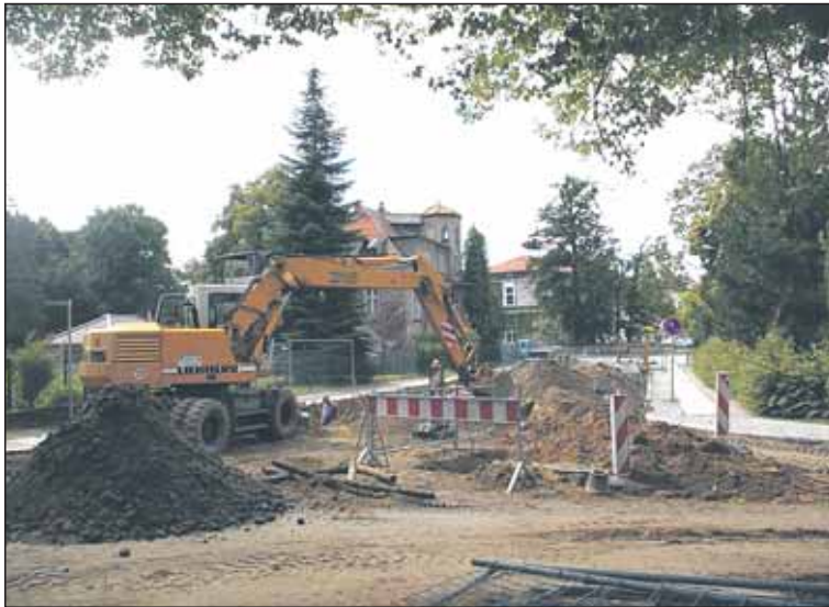
Bis 23.11.2007 wird die Lessingstraße neu gebaut, einschließlich der Verlegung von Rohrleitungen. Bitte die Baustelle weiträumig umfahren und die Umleitungen beachten.
