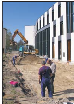
Ratzeburgstraße: wegen Neubau bis voraussichtlich 22.6. gesperrt.
