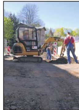
Bis September 2007 sind die Arbeiten an der Erich-Mühsam-Straße zwischen Goethe- und Breite Straße geplant.
