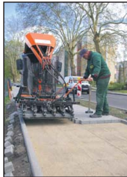
Fahrradweg nach Sommerfelde: Für Mitte Mai ist die Fertigstellung geplant. Größte Probleme: Grundstücksfragen/Geländeprofil
