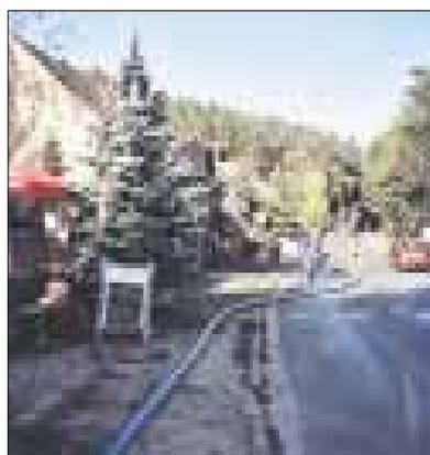
Die Trinkwasserleitung ist für den unterirdischen Rohrvortrieb vorbereitet.
