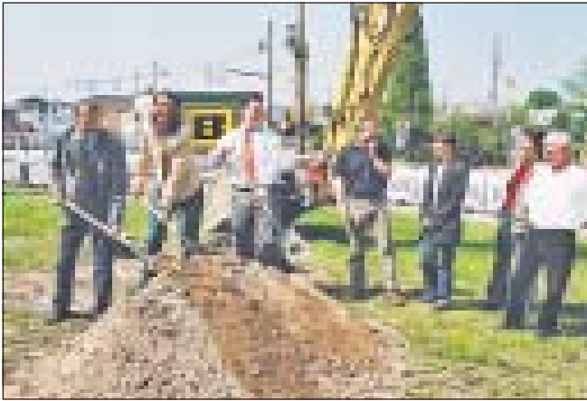
Für den neuen Knotenpunkt Eisenbahnstraße/Bergerstraße/Bahnhofszufahrt erfolgte der erste Spatenstich am 12.5.2006. Lutz Landmann, 1. Beigeordneter, Kerstin Fines-Keck, Niederlassungsleiterin Landesbetrieb für Straßenwesen, und Marc Berger von der ausführenden Firma BERGER BAU griffen dafür symbolisch zum Spaten. Fotos:Stö.-
