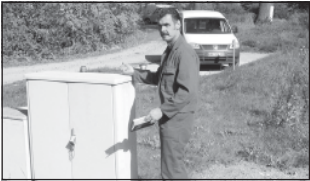
Rainer Zuch, Meister Kanalnetz/Mehrwärksbedienung
