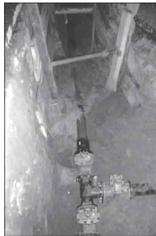
Neue Schieber nach erfolgreicher Arbeit.
