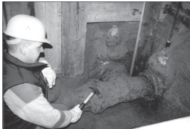
Wilfried Rohde prüft Trinkwasserrohr vor der Demontage.
