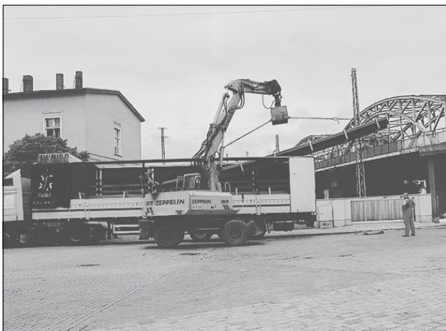
Die Schutzrohre werden abgelagert. Hinter dem LKW befindet sich die Startgrube der 80-m-Bohrung.
