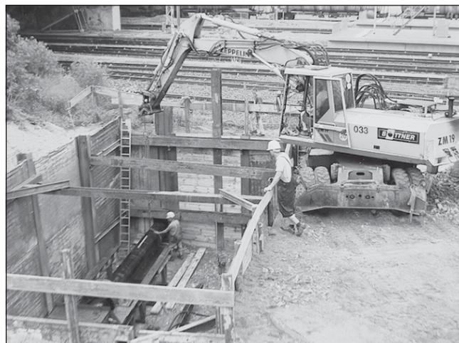
Die Bohrtechnik ist in Position. Ca. 10 Tagen sind für die zwei Pressungen über 80 m geplant.
