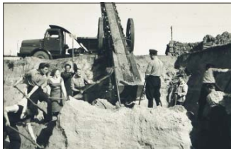
Mai 1959, AWG-Block 13, Westend, künftige Otto-Nuschke-Straße 5/7. 4,5 m tief musste die Baugrube ausgeschachtet werden – per Hand!!! So kamen u.a. die nötigen Aufbaustunden zusammen. Foto: Archiv StU.
