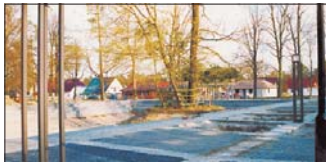
Parkplatz auf die entstehenden Außenanlagen vor der Kantine.
