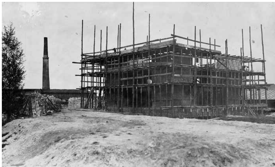
Hindenburgturm, heute Wasserturm Finow, während der Bauarbeiten, 1917
