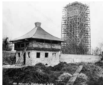
Hindenburgturm, heute Wasserturm Finow, während der Bauarbeiten, 1917
