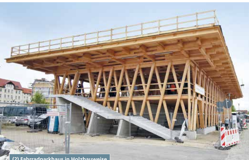
(2) Fahrradparkhaus in Holzbauweise
