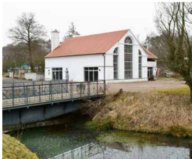
Altes Walzwerk, heute Blechen-Haus benannt nach dem Maler Carl Blechen, heute befindet sich dort das Atelier des Metallbildhauer Eckhard Herrmann. Foto: Wolfgang Stohr, 2022
