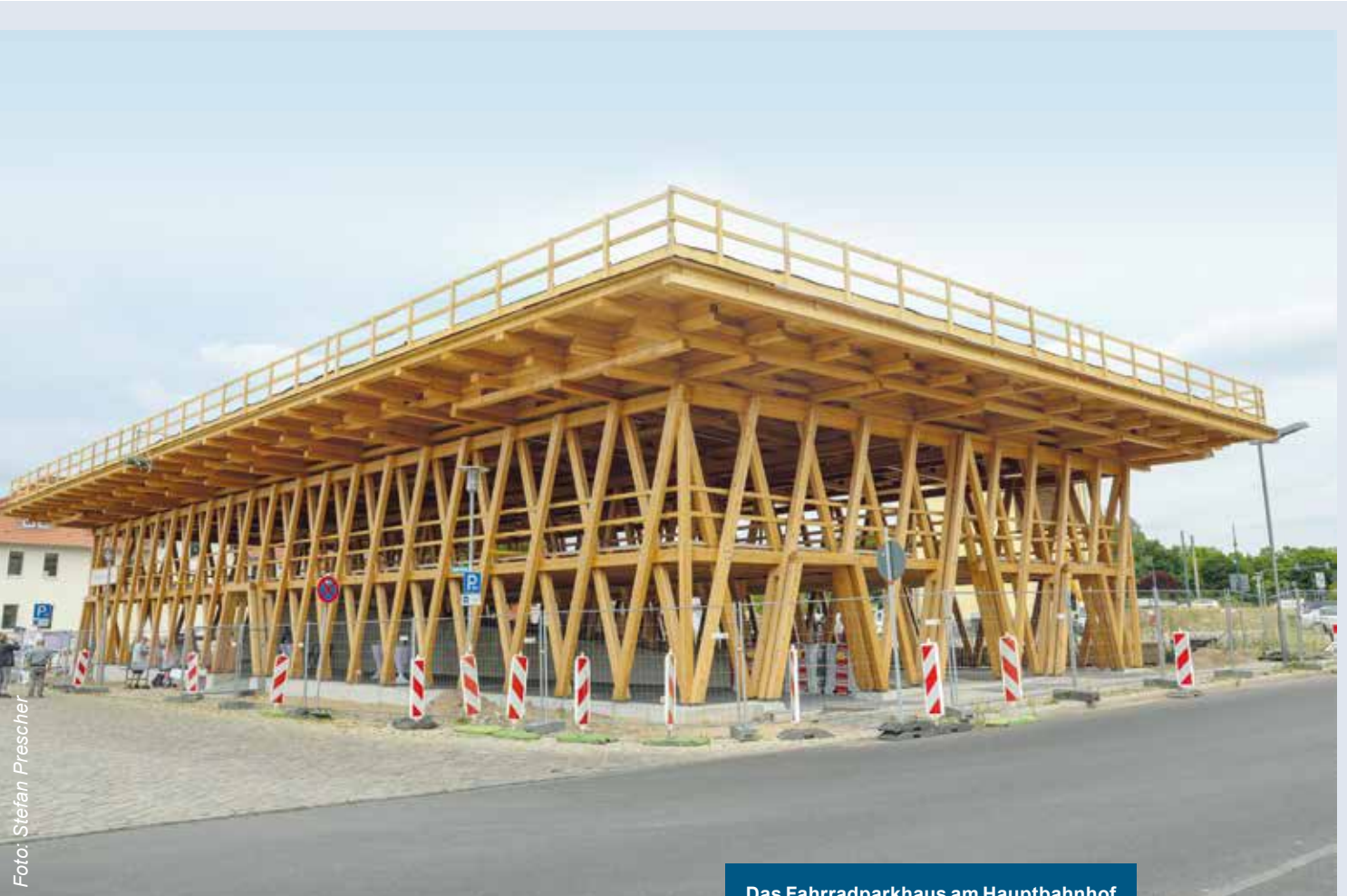
Das Fahrradparkhaus am Hauptbahnhof
