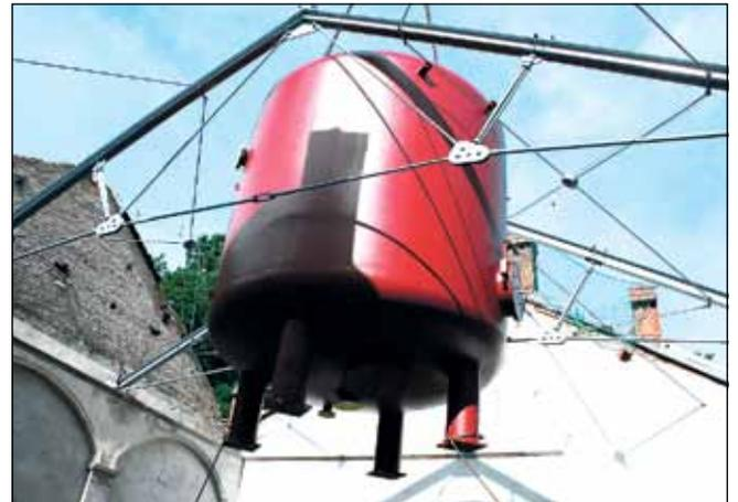
Der schwierigste Teil beginnt, das Einfädeln der Kessels durch die Verspannungen der Dachträger.
