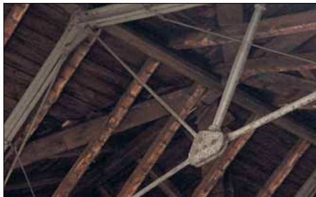
Die alte Dachkonstruktion muss denkmalgeschützt teilweise erneuert werden
