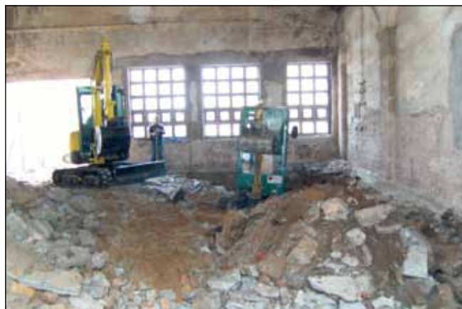
Abbruch des Fußbodens in der Filterhalle
