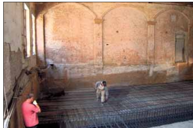
Einbau des neuen Fußbodens; hier sind die alten Stuckelemente gut sichtbar
