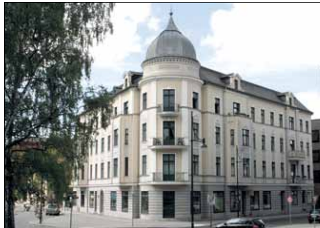
Einen schönen Blick auf den Park am Weidendamm und das neue Kreishaus bietet das Haus in der Schicklerstraße 1 aus dem Jahr 1898.
