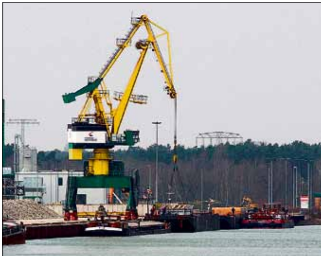
Der Binnenhafen heute: Der Doppelenkerwippdrehkran beim Be- und Entladen der Schiffe.
