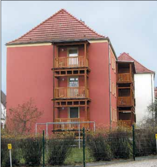
Die Modernisierung der Werbelliner Straße 53 wurde in diesem Jahr umgesetzt.
