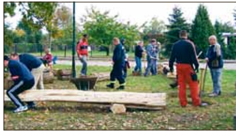
Während des Baus des Spielplatzes
