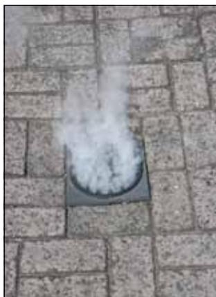
Was ist eigentlich der Grund dafür, dass Schmutzwasserkanäle ausgenebelt werden? Der ZWA ist für den ordnungsgemäßen Betrieb des Schmutzwassernetzes zuständig. Dazu gehört auch die Funktionsprüfung hinsichtlich der Ordnungsmäßigkeit der Anschlüsse an das Kanalnetz.
