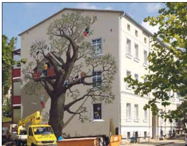
Neue Fassade in der Breiten Straße 104.
