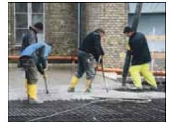
Anne Fellner. Der Rohbau ist abgeschlossen. Eine solide Stahlbetondecke und Dichtungen, die in das historische Mauerwerk eingezogen wurden, schützen künftig vor Feuchtigkeit. Fast 200 Pfähle verankern das gesamte Haus im Untergrund. Derzeit arbeiten Trockenbauer an der Verkleidung alter Stahlträger und der Ziegelwände. Die Holzfenster arbeitet eine Spezialfirma in Sachsen auf.
