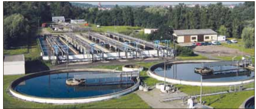
Investitionen in die Kläranlage Eberswalde nach 1990
