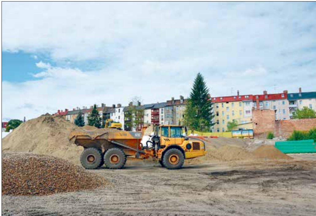
Die großflächige Sicherung und Sanierung des Geländes der ehemaligen Dachpappenfabrik geht voran.
