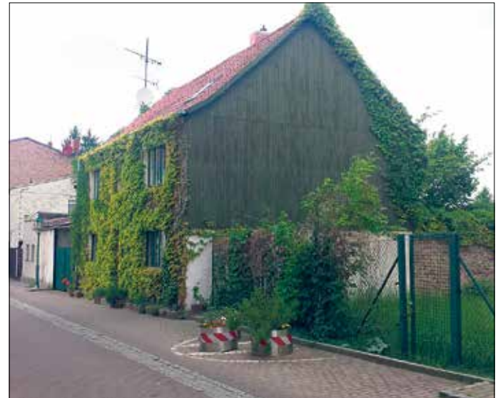
Fassadenbegrünung in Eberswalde.
