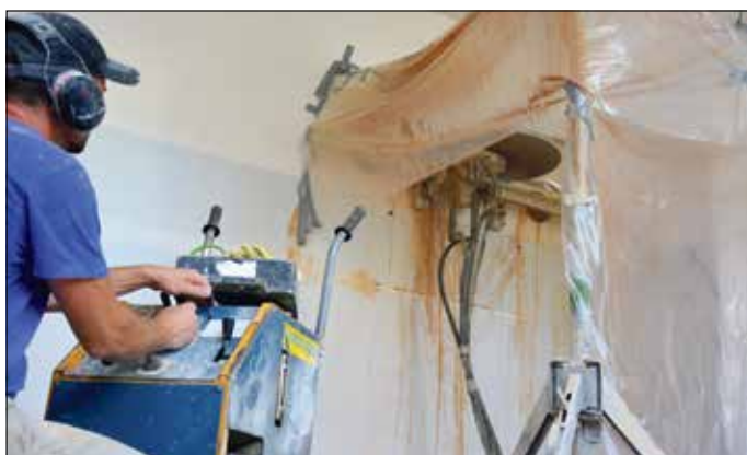
Vorbereitungsarbeiten für Brandschutzmaßnahmen in der Grundschule Finow.
