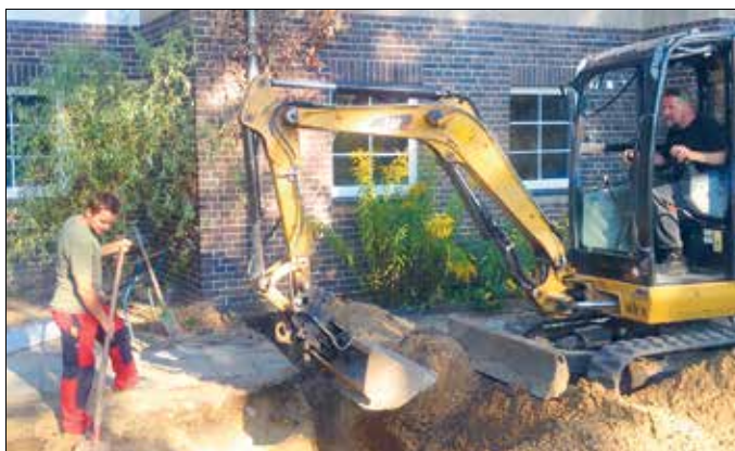
Sebastian Seliger und Andreas Overwaul mit Schaufel und Mini-bagger bei der Arbeit.
