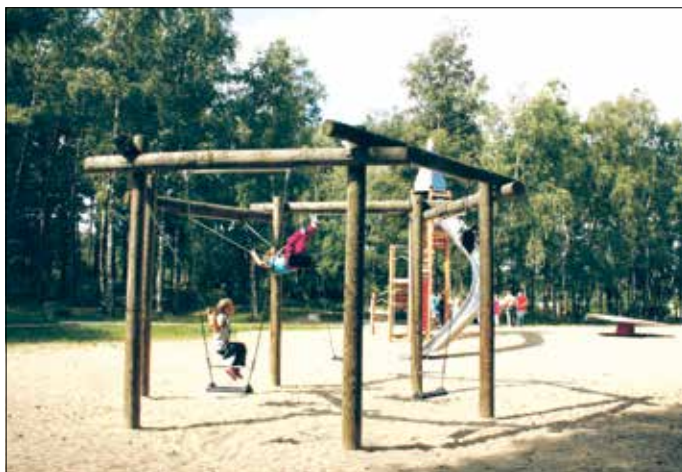
Der Bauhof und das Tiefbauamt reparieren jedes Jahr Spielgeräte im Stadtgebiet.
