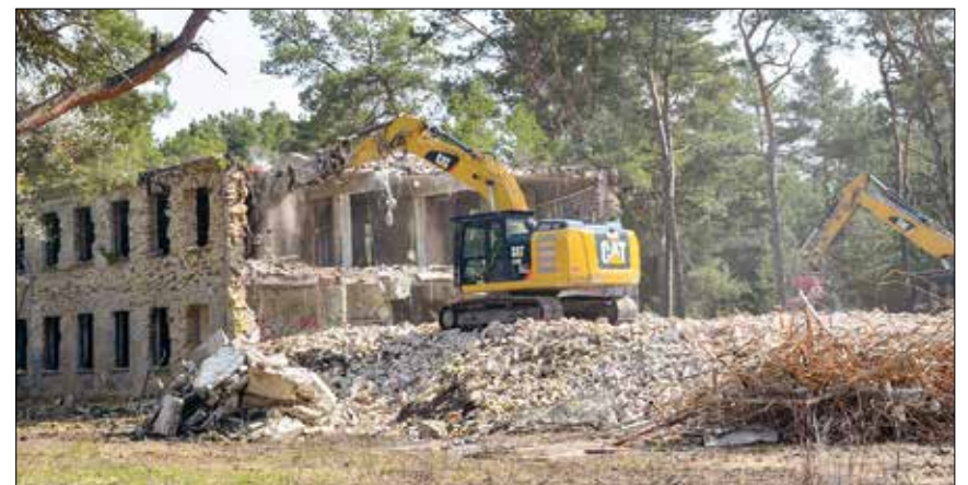
Eine von vielen Ruinen der Märkischen Heide wird nach Jahren beseitigt, 1,2 Millionen Euro fließen in die Konversionsfläche.
