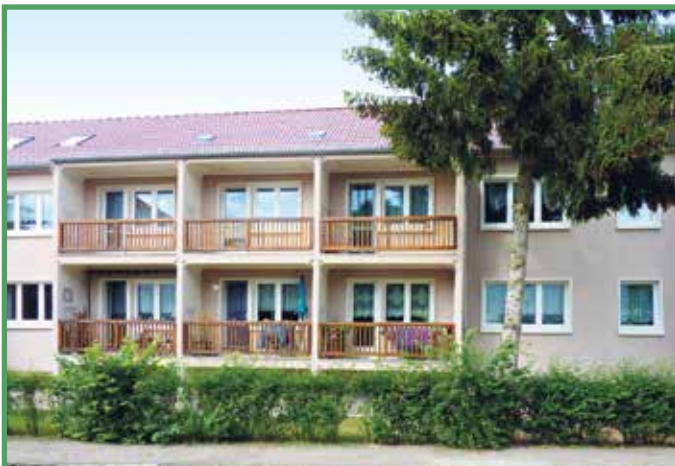
Locker-luftig wirken die neuen Balkone in der Tornower Straße. Die Holzverkleidung passt gut zu den umliegenden Gebäuden.
