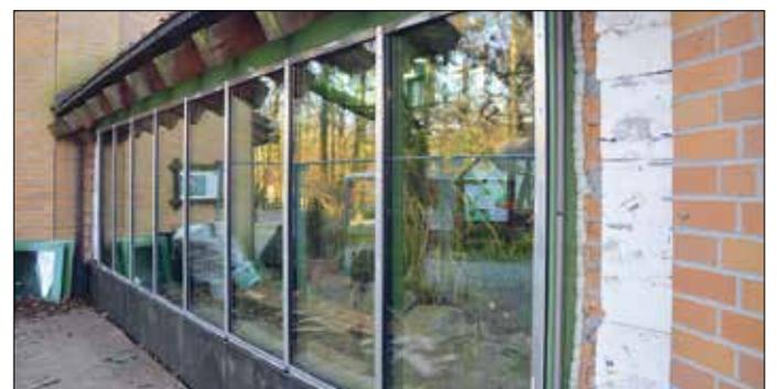
Die neue Fensterfront am Urwaldhaus wird bei laufendem Betrieb vor die alte montiert, so dass der Besuch des Hauses jederzeit möglich ist.
