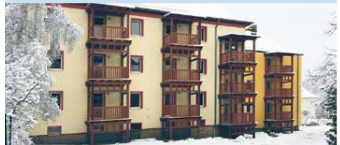
Weiß eingezuckert waren auch die Häuser in der Boldtstraße im vergangenen Winter. Auch in diesem Jahr bittet die WHG darum, den Schnee von Balkonen und Terrassen rechtzeitig zu entfernen.
