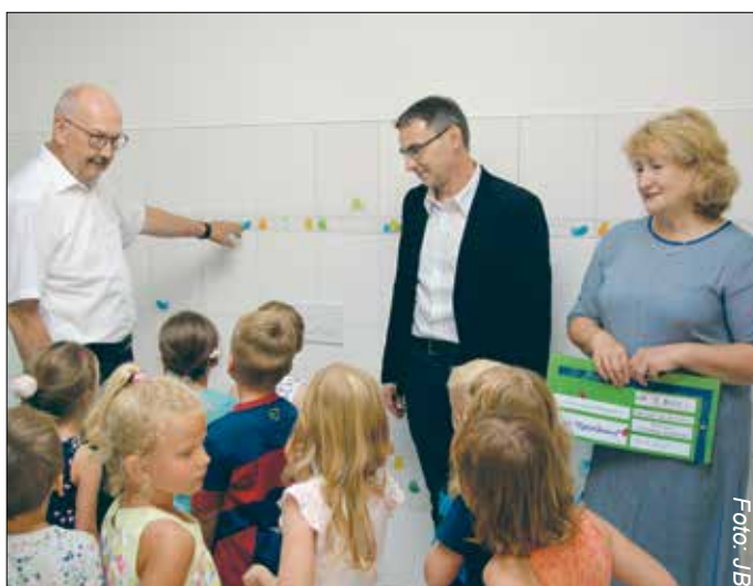
Bürgermeister Boginski, Britta Schulz und Frank Haupt sahen sich gemeinsam mit den Kindern den Baufortschritt an.
