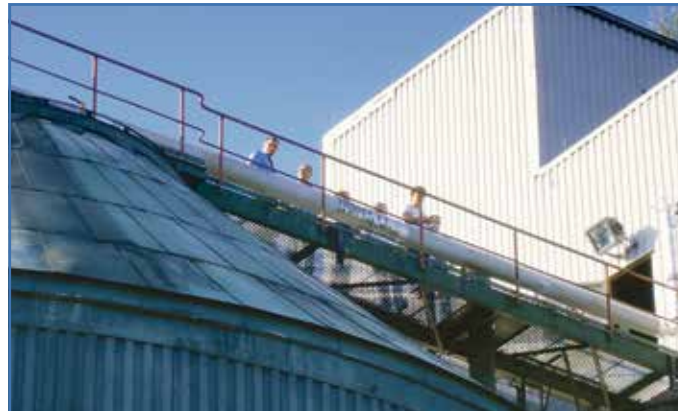
Blick vom Faultrum der Kläranlage Eberswalde Foto: ZWA
