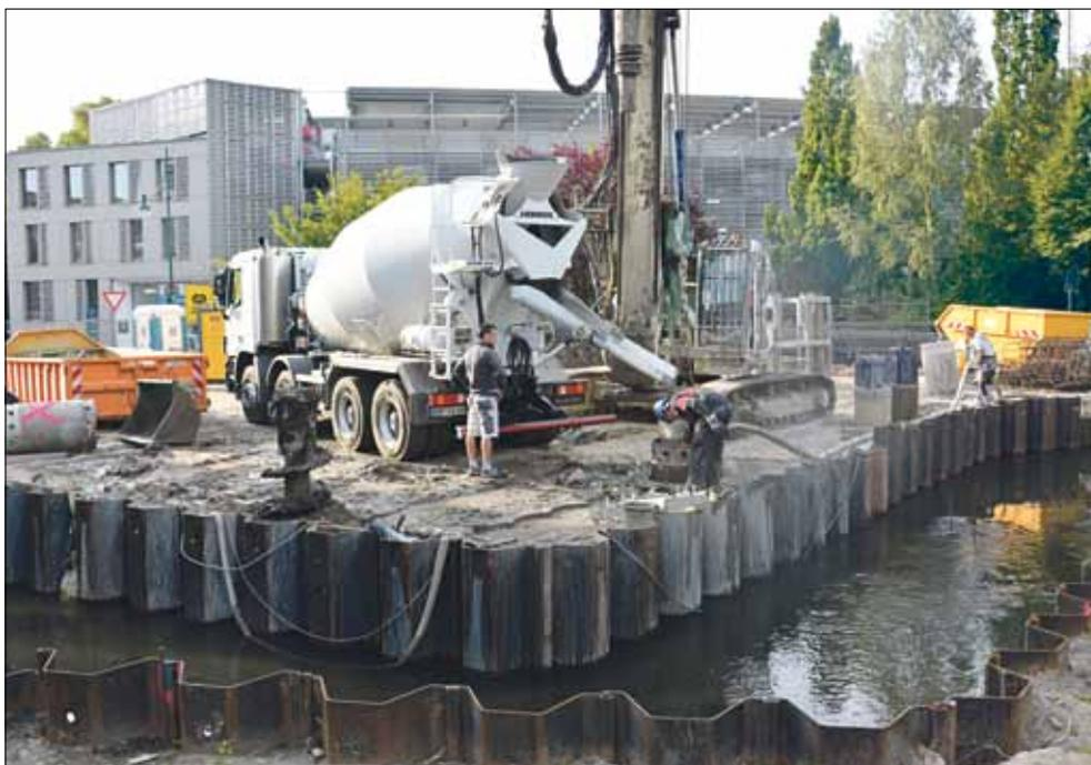
Spundwände aus Stahl sichern den für die Dauer der Bauarbeiten provisorisch umgeleiteten Flusslauf der Schwärze.
