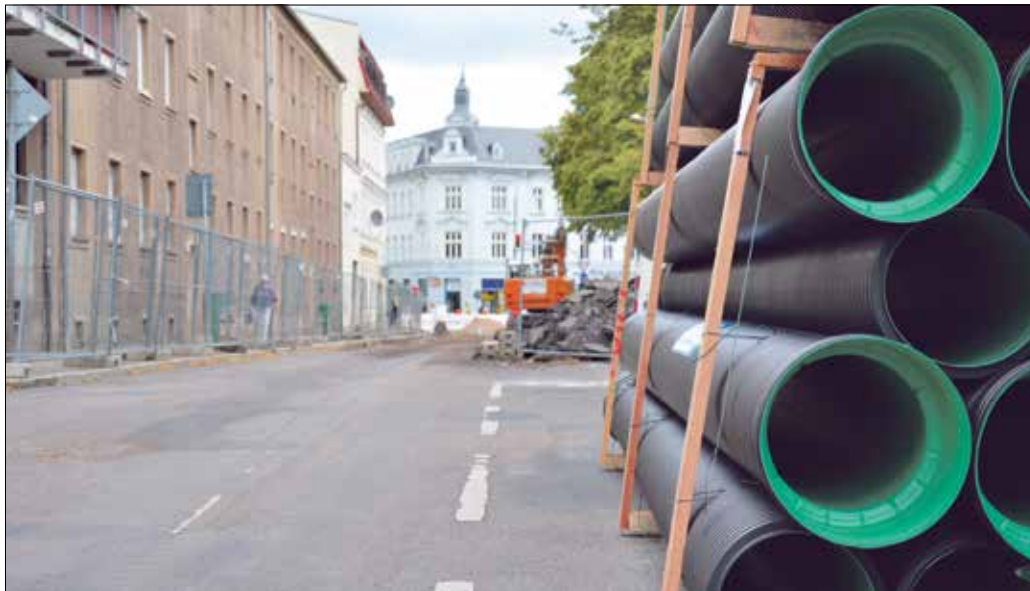
Seit Ende Juni wird in der Rudolf-Breitscheid-Straße gebaut. Verkehrseinschränkungen wird es bis Frühsommer 2017 geben.
